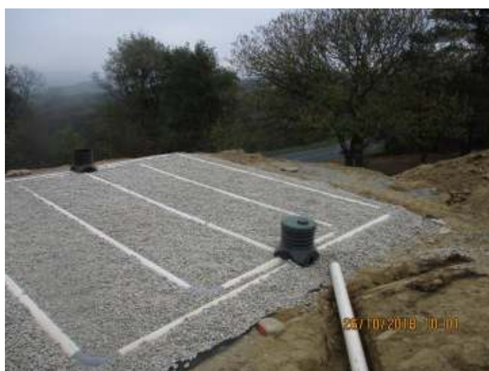
Filtre à sable non drainé
