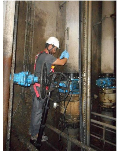
**Opération de contrôle d'un débitmètre**
