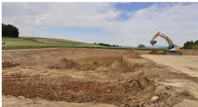
Combe Boussole à Chuzelles : Terrassement pour la création du bassin de rétention des eaux de ruissellement
