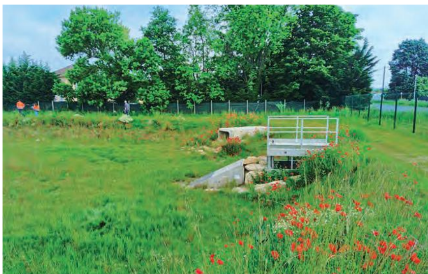
Bassin de rétention de Combe Boussole à Chuzelles
