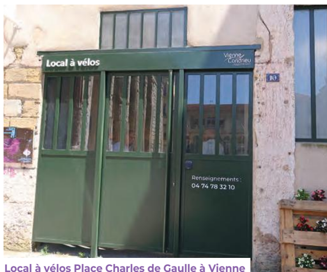
Local à vélos Place Charles de Gaulle à Vienne
