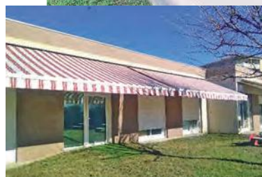
EAJE « Grain d'Aile » : remplacement des stores bannes
