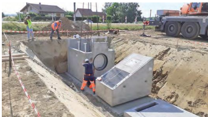
Combe Boussole à Chuzelles : Pose de la chambre de régulation
