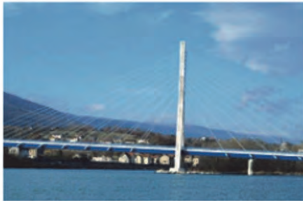
Pont à haubans : Pont de Seyssel
