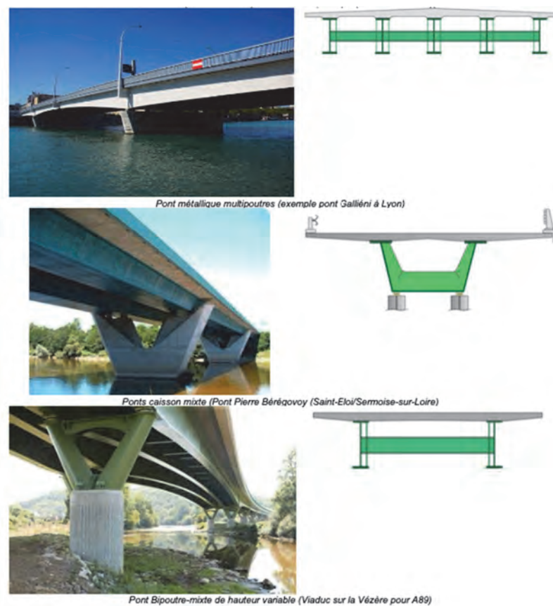
Figure 17 : Exemples de pont poutre-caisson, de pont multi-poutres, de pont caisson-mixte et de pont bi-poutre-mixte (études BG 2022)
