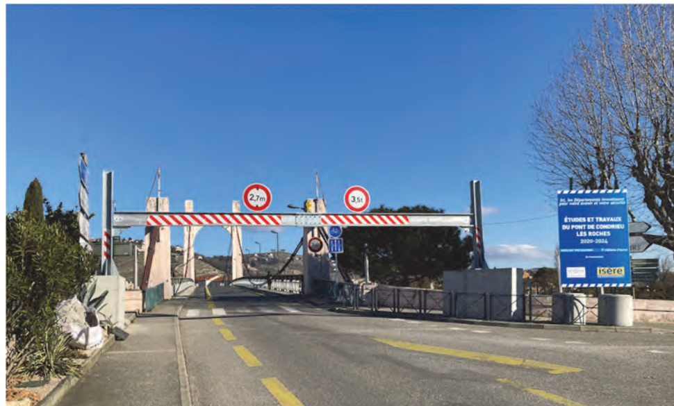
Figure 9 : Vue du dispositif de limitation de gabarit de l'ouvrage actuel – côté Roches-de-Condrieu
