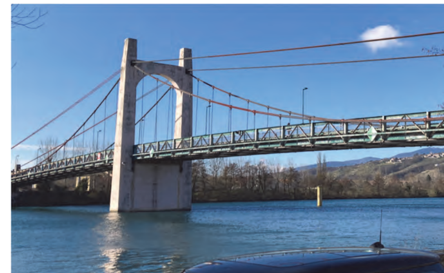
Figure 8 : Vue sur la pile centrale du pont actuel depuis la rive droite
