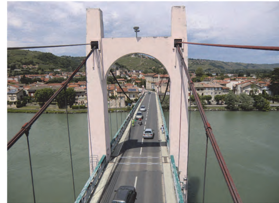
Figure 7 : Vue de la chaussée et de la pile centrale du pont actuel en 2014 (IDP 2014)
