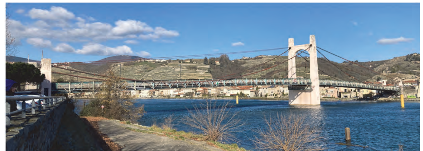
Figure 3 : Vue sur le pont actuel – photo de mars 2023
