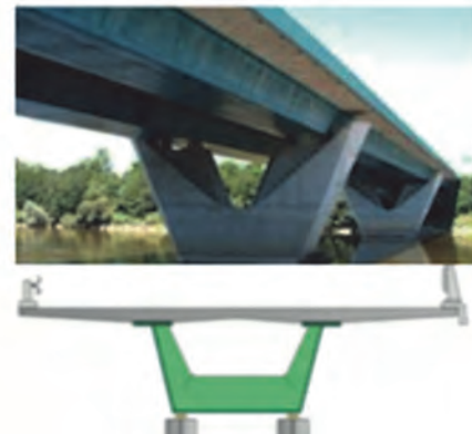
Pont en caisson mixte : Pont de Sermoise-sur-Loire
