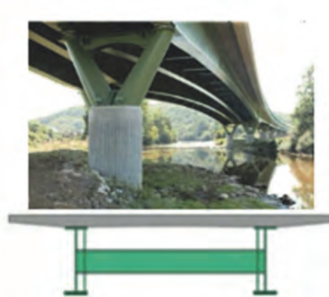
Pont bipoutre-mixte de hauteur variable : Viaduc sur la Vézère A 89
